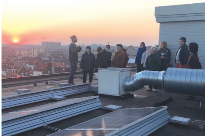
Plus de cent panneaux photovoltaïques ont été installés sur le toit du logement social
